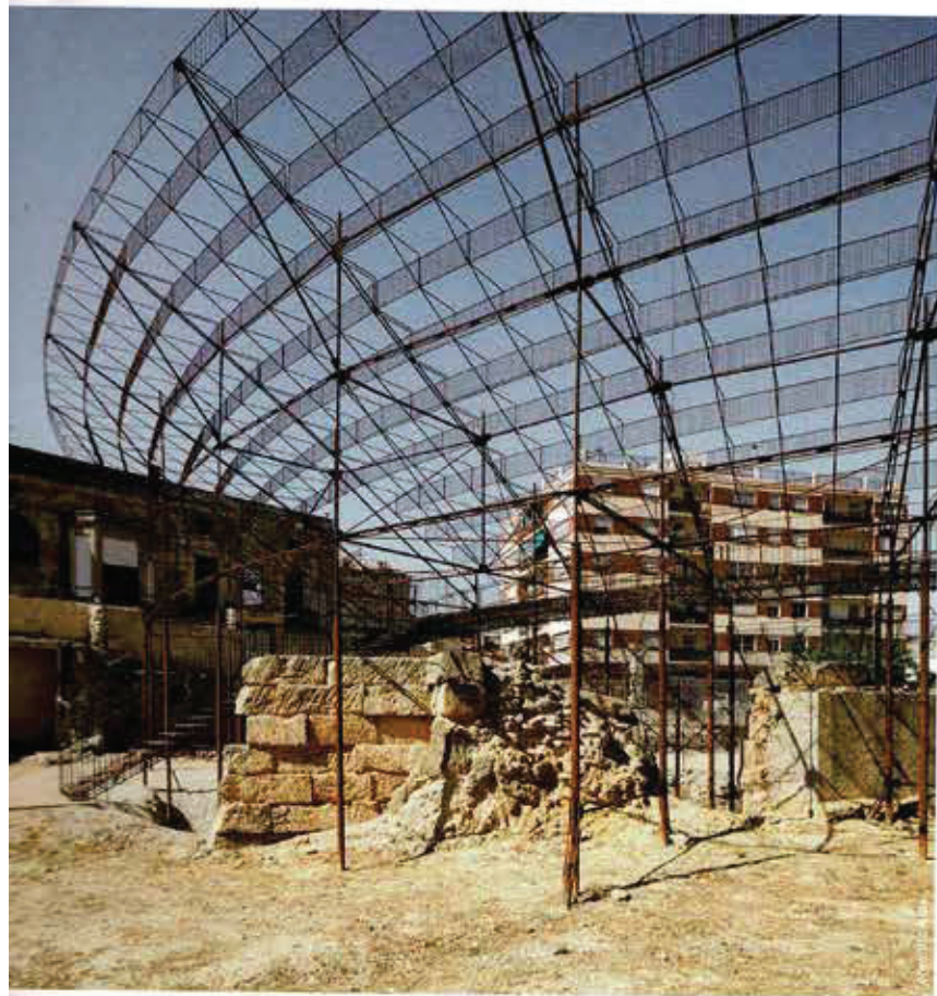
Vista, da sotto, della cavea tridimensionale metallica From below, a view of the three-dimensional metal cavea
