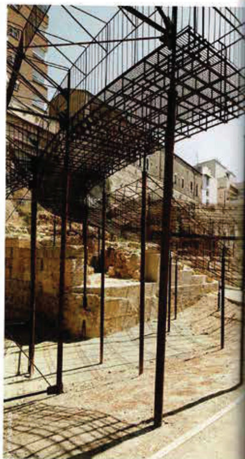
Dettaglio della passerella in barre di acciaio ossidato Details of the walkway in oxidized steel bars
