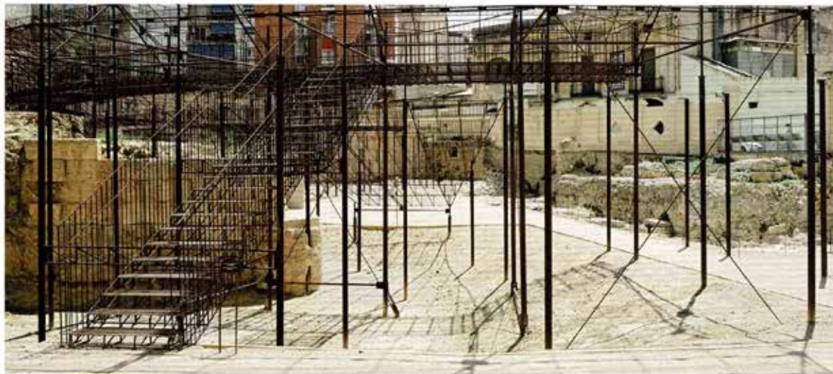
17, 18, 19 vedute della scala, della passerella e delle gradinate della cavea views of the staircase, the walkway and the steps of the cavea
